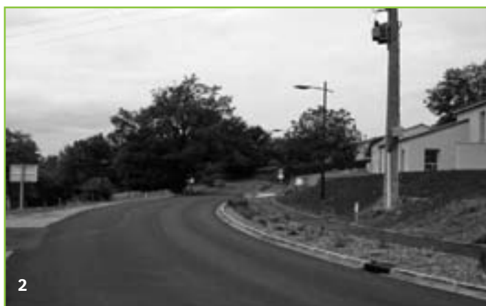
1 et 2) Entrée sud de Saint-Simon, route départementale 17. Revêtement en enrobé (supplément 33 000 € aux frais de la Commune)
