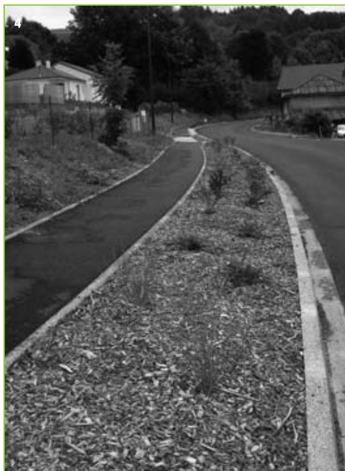
4) Route du Puy Mary, fleurie, modernisée et sécurisée (dans le cadre du PAVEP : Plan d'Accessibilité de la Voirie et des Espaces Publics).
