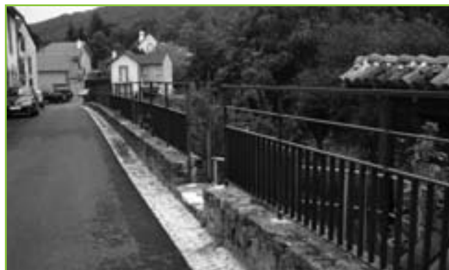
6) Chemin de Vergnes : élargissement de la voie et reconstruction d'un mur à l'ancienne. Harmonie des matériaux, pierres, galets et métal vieilli.
