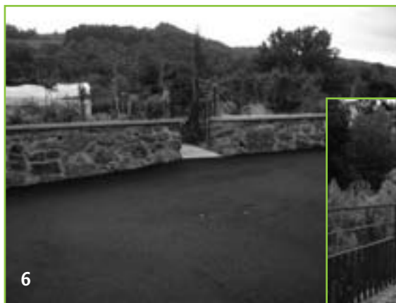
6) Chemin de Vergnes : élargissement de la voie et reconstruction d'un mur à l'ancienne. Harmonie des matériaux, pierres, galets et métal vieilli.
